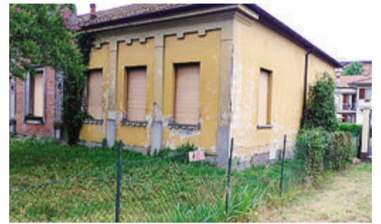
La facciata a pezzi dell'ex asilo Bulloni di viale Piacenza
